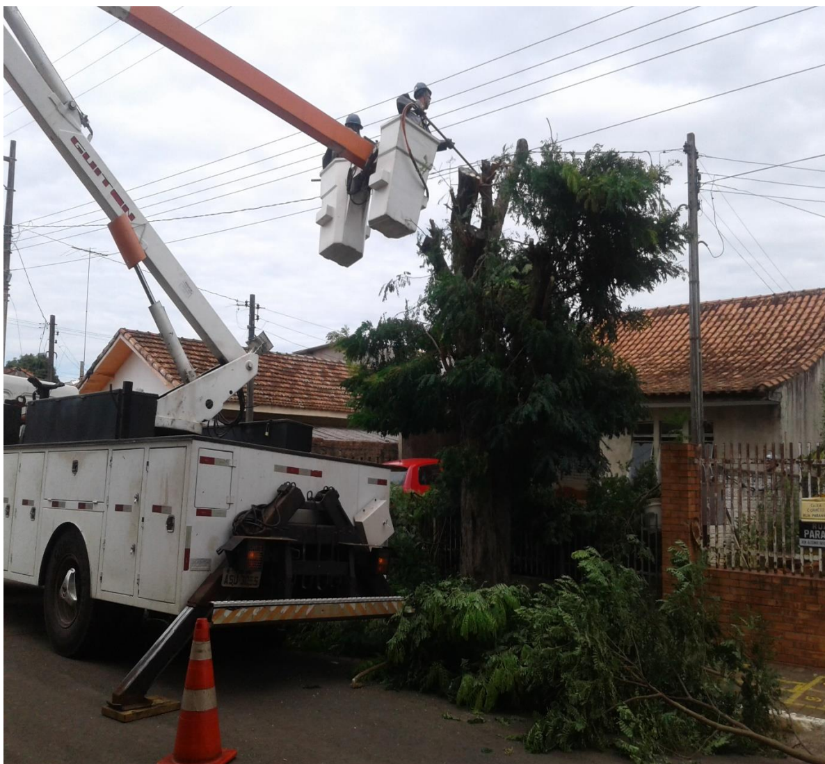
Figura – 48. Poda sobre a rede elétrica realizada pela COPEL
