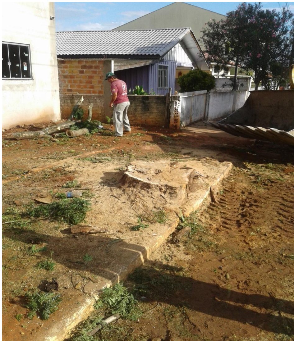
Figura 18 - Remoção de tocos
