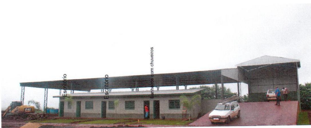
Figura 05: vista frontal da parte administrativa do barracão de triagem e aos fundos o local onde funcionará a operacionalização dos resíduos.
